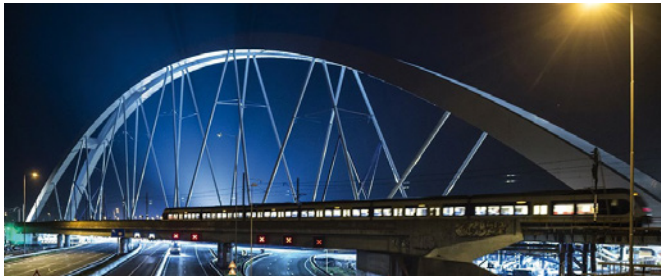
Bild 7 Zandhazenbrug in den Niederlanden mit rund 7 000 t S460M/ML bis zu einer Blechdicke von 120 mm Zandhazenbrug in the Netherlands with around 7 000 t of S460M/ML up to a plate thickness of 120 mm
