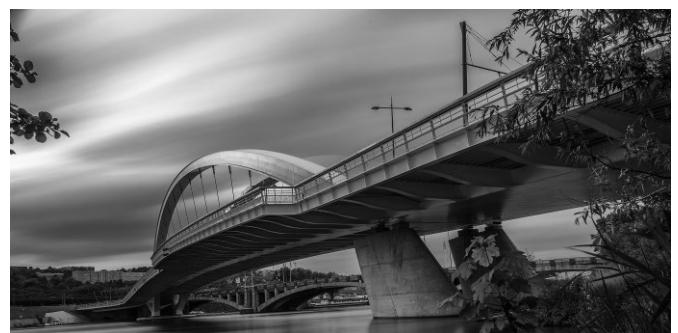
Bild 1 Höherfester thermomechanisch gewalzter Stahl (S460ML) im Brückenbau, Raymond Barre Brücke in Lyon, Frankreich Higher strength thermomechanically rolled steel (S460ML) in bridge construction, Raymond Barre Bridge in Lyon, France
