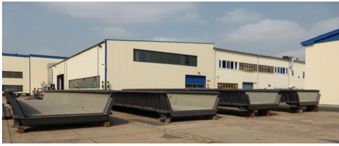
Bild 2 Dickblechtrugbrücken bereit für die Installation Trough bridges with thick deck plates ready for installation
