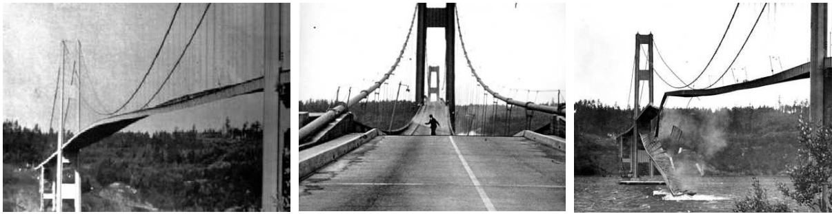
Bild 1.4: Schwingungserregung und Einsturz der Tacoma Narrows Bridge
