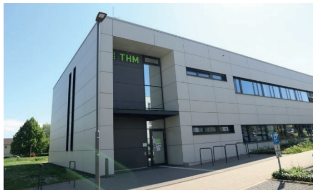
Bild 2: Gebäude C1 in Friedberg
